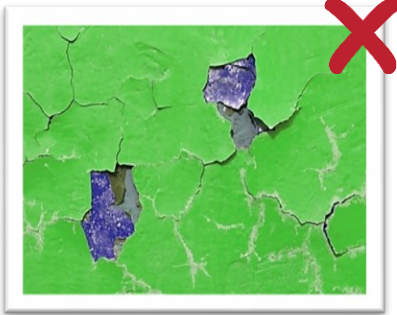
Figura 18: Ang mga bitak, pagbabalat ng pintura, nakalalasang materyal sa mga dingding/sahig ay mapanganib.
